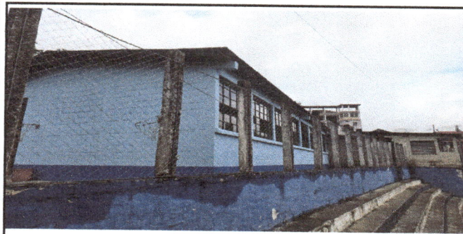
Cambio de malla perimetral terminado
