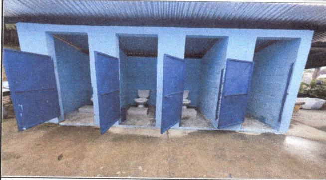
Adaptación de gradas a sanitarios para que sean aptos para niños de preprimaria
