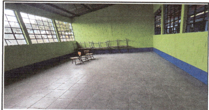
Piso de las aulas, terminado con piso cerámico
