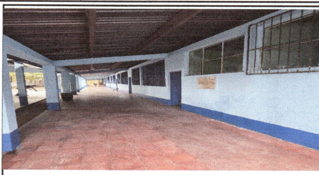
Nueva pintura exterior del edificio
