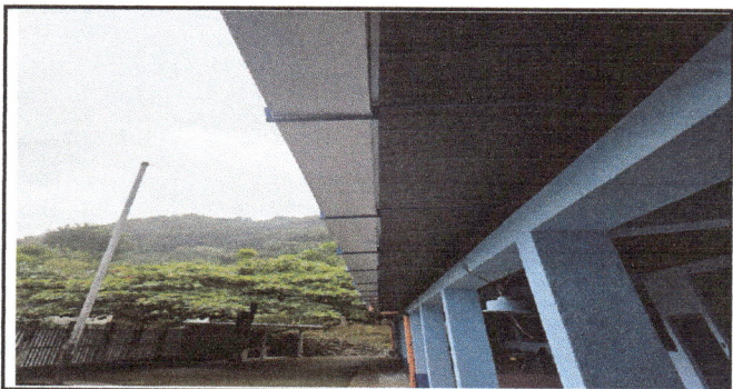
Cambio de canal de aguas pluviales
