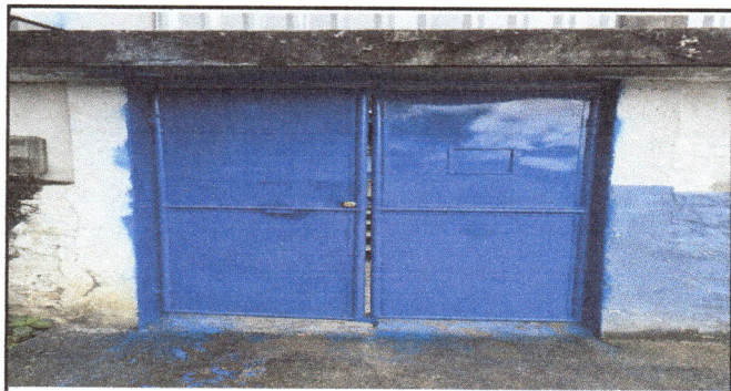
Portón principal remozado
